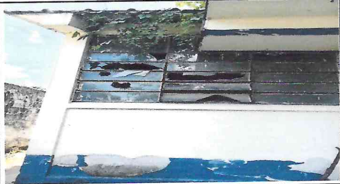
Foto 7: Mantenimiento a pared
