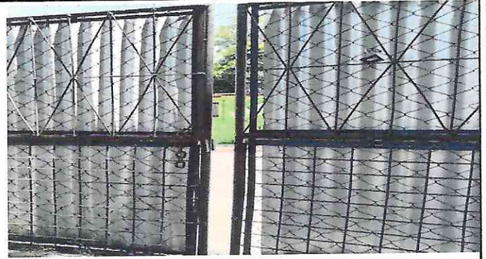
Foto 8: Mantenimiento a portón
